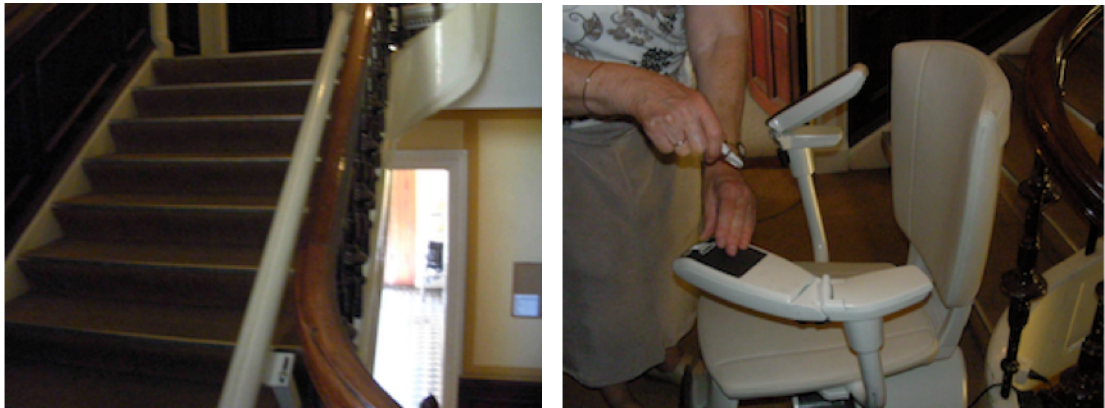
図 4 共同住宅の階段に設置された階段昇降椅子式リフト
